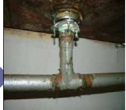
PARTE INFERIOR DE FREGADERO
