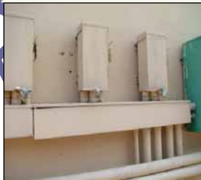
CUBIERTA DE CANAL DE CABLES SIN TORNILLOS
