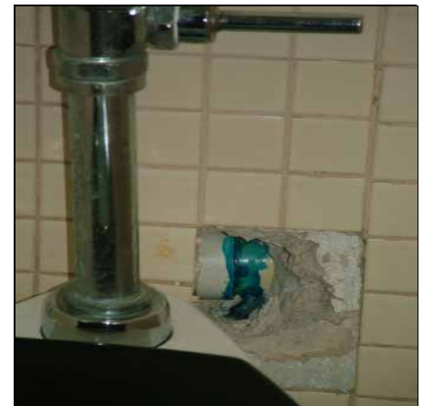
PARED ÁREA INODOROS BAÑO DAMAS
