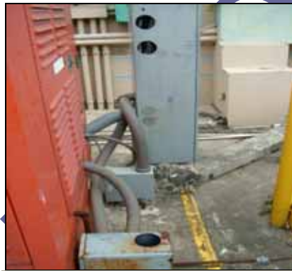
EXTERIOR ÁREA PLANTA ACCESOS SIN SELLAR
