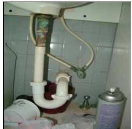
TUBERÍA DESAGUE LAVAMANOS BAÑO LAUNDRY
