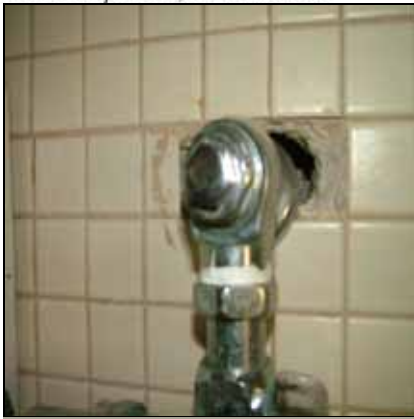
TERMINACIÓN URINAL BAÑO CABALLEROS
