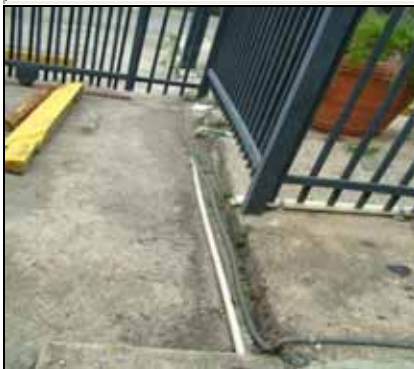
TUBO FLEXIBLE EXPUESTO LETRERO LAUNDRY
