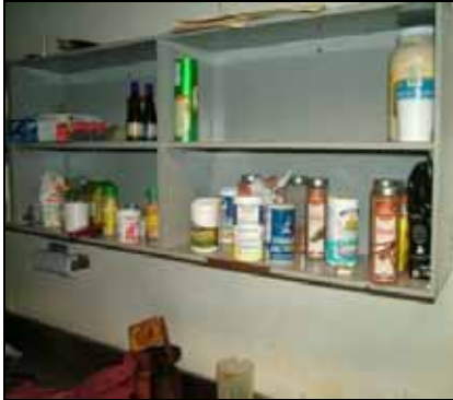
TABLILLERO LAMINADO - NECESITA REPARACIÓN
