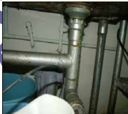
PARTE INFERIOR DE FREGADERO
