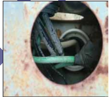
EXTERIOR ÁREA PLANTA ACCESOS SIN SELLAR
