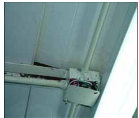
ÁREA DE LAUNDRY - INST. CORRECTAMENTE TAPA CIEGA
