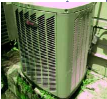
COMPRESOR UNIDAD DE WIC Y EVIDENCIA LÍNEA REPARADA
