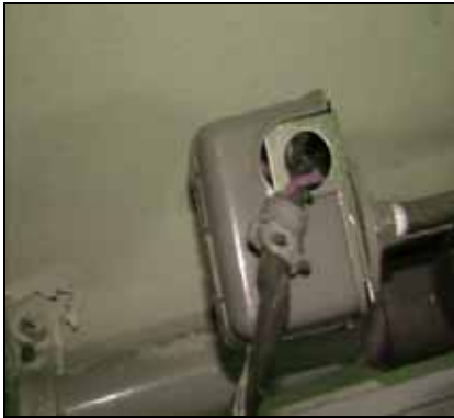
AREA DE BOMBAS Y TANQUES DE AGUA
