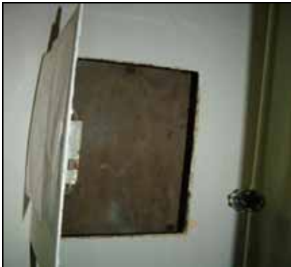
ÁREA DE POSIBLE PANEL ELÉCTRICO O TELÉFONO
